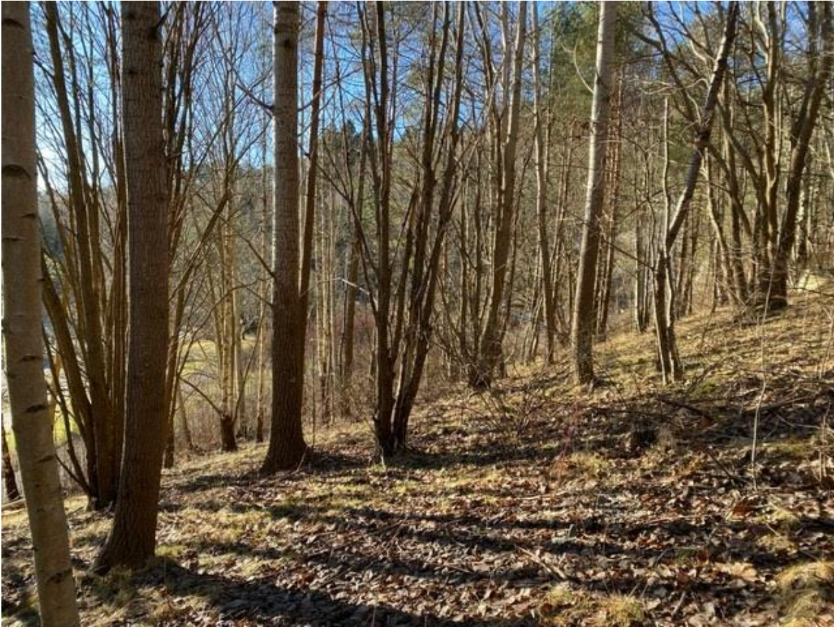
Figur 8, Slänt från GC-väg mot Rymdtorget spårvagnshållplats.
