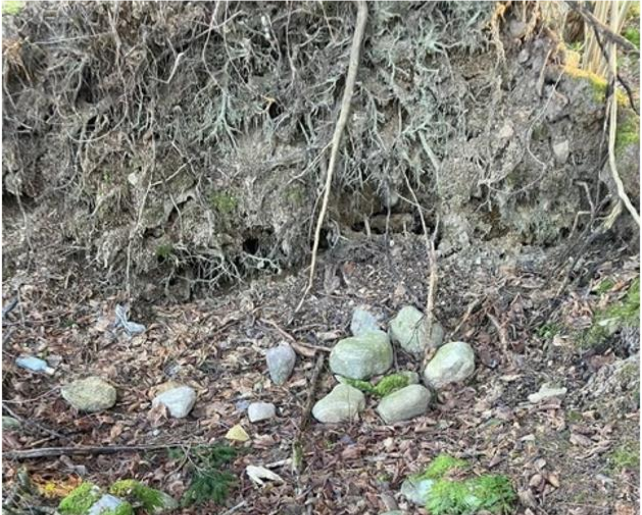
Figur 7, I rotvältan kunde blockig sandig morän verifieras.
